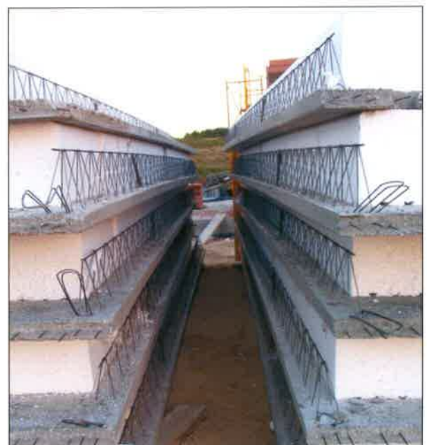
Apilado de Paneles Planos en obra dispuestos para su colocación.
