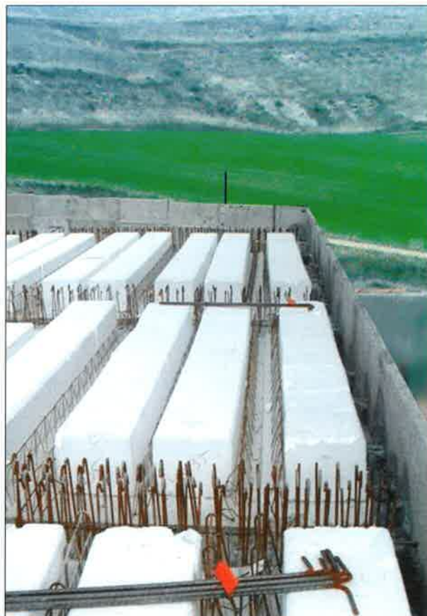
Vista forjado de Panel Plano con muros MPR.
