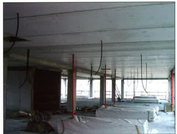
Vista inferior forjado de Pisos con Paneles Planos.
