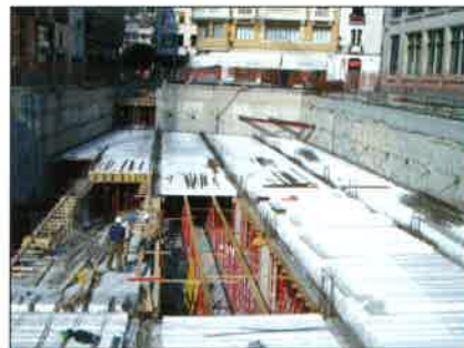
Paneles Planos, Vigas y pilares prefabricados.
