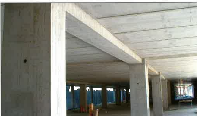
Vista general forjado de Garajes con Paneles Planos.
