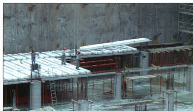
Colocación de P. Plano con mínima mano de obra y con grúa Torre por su bajo peso.
