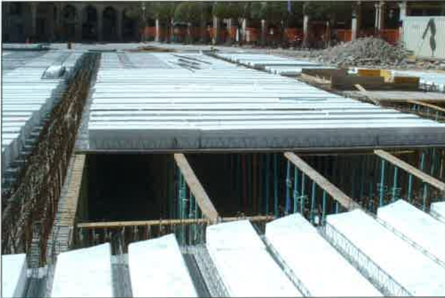
Vista forjado con Paneles Planos.
