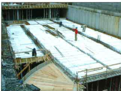
Forjados con P. Planos colocado.
